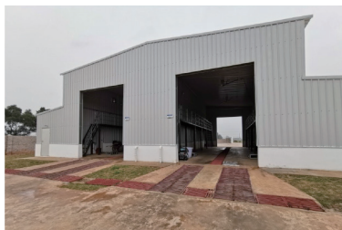
图 3-6 洗消中心清洗区
