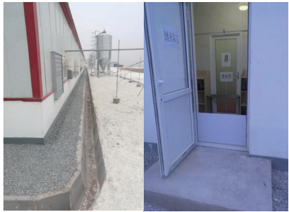
图 5-12 猪舍外铺设碎石和设置挡鼠板
